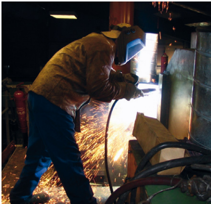
Schweißer beim Lichtbogenfugen zur Entfernung eines Risses im Maschinenkörper.
