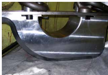
Einschweißen eines neuen verstärkten und kraftfußoptimierten Lagers.
