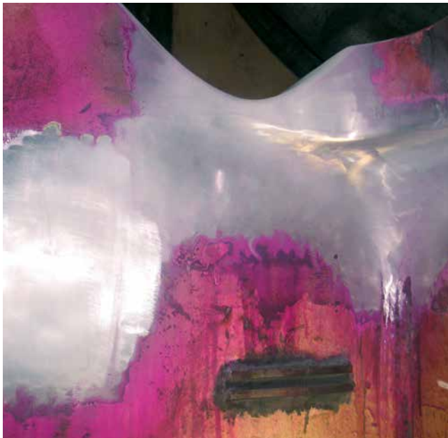
Reparaturschweißung mit aufgeschweißten und kerbarm umschliffenen Blechübergängen.
