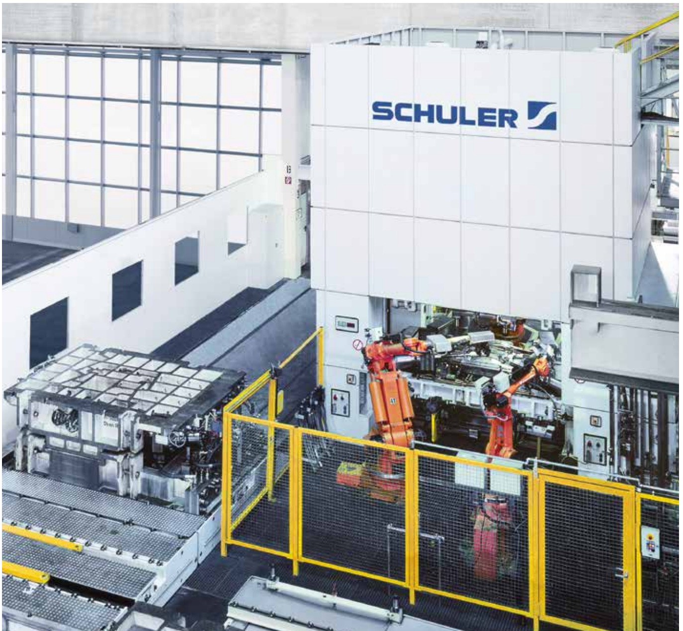
Vollautomatische IHU-Anlage eines deutschen Automobilherstellers.
