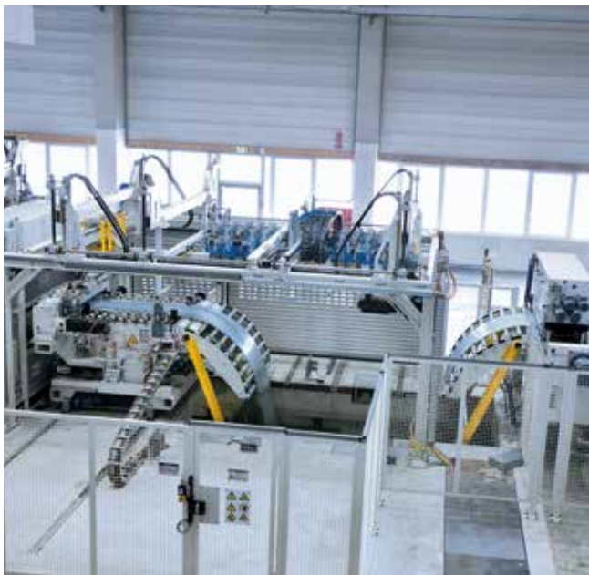
Bandzuführanlage und Platinenlader in Kombination.
