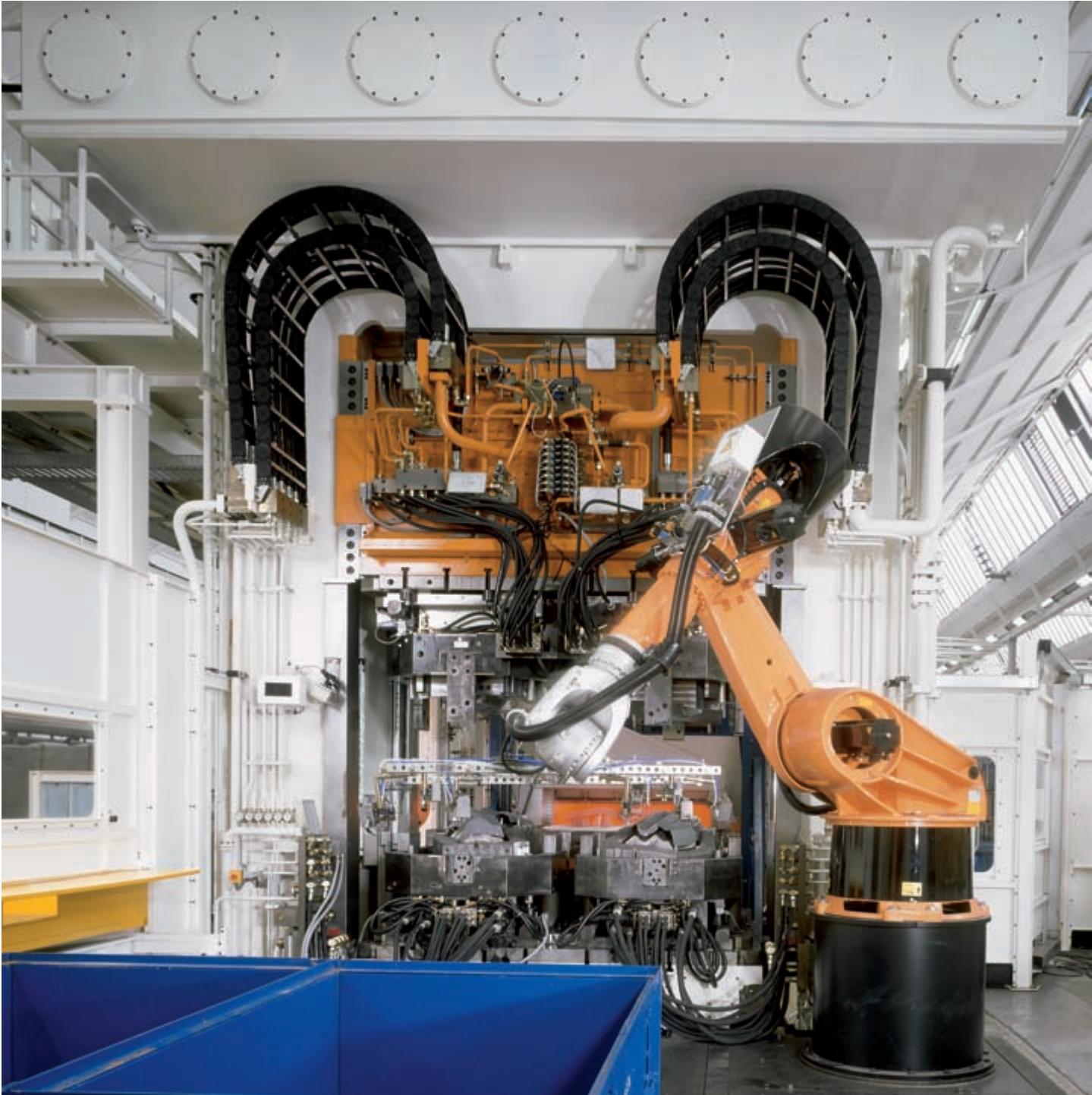
Presse d'emboutissage hydraulique 8000 KN équipée d'un outil refroidi à l'eau. Des robots avec préhenseurs spécifiques assurent l'empilage des composants finis.
