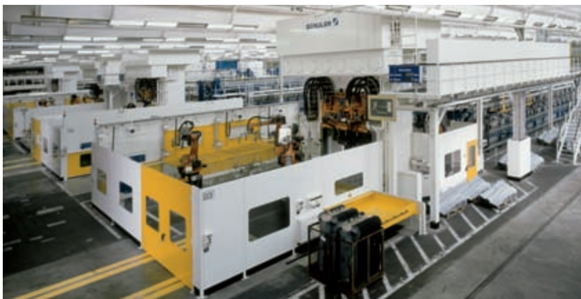
Lignes de fabrication robotisées avec four continu à rouleaux et presses hydrauliques.
