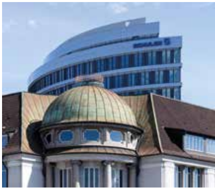
Schuler Innovation Tower, Göppingen.
