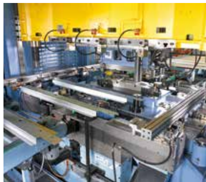
Die maximale Ausbringungslleistung der Anlage beträgt 12 Hübe/Minute.
