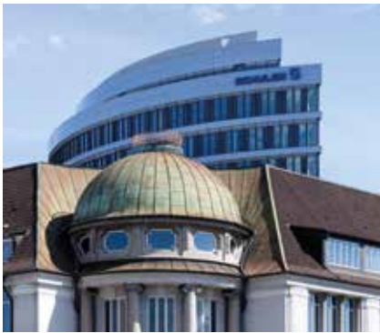
Schuler Innovation Tower, Göppingen.
