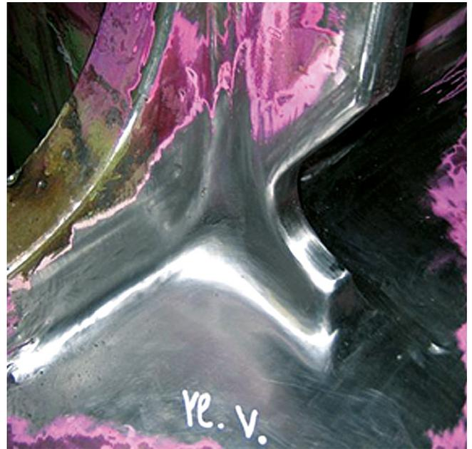
» Reparaturschweißung mit aufgeschweißten und kerbarm umschliffenen Blechübergängen.
